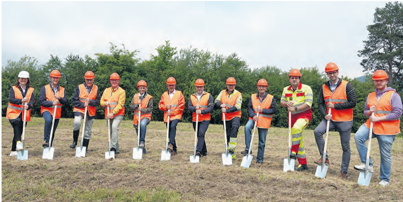
Es geht los: Nach langer Planung erfolgte am Montag der Spatenstich. Die Bauzeit beträgt voraussichtlich 14 bis 15 Monate.
