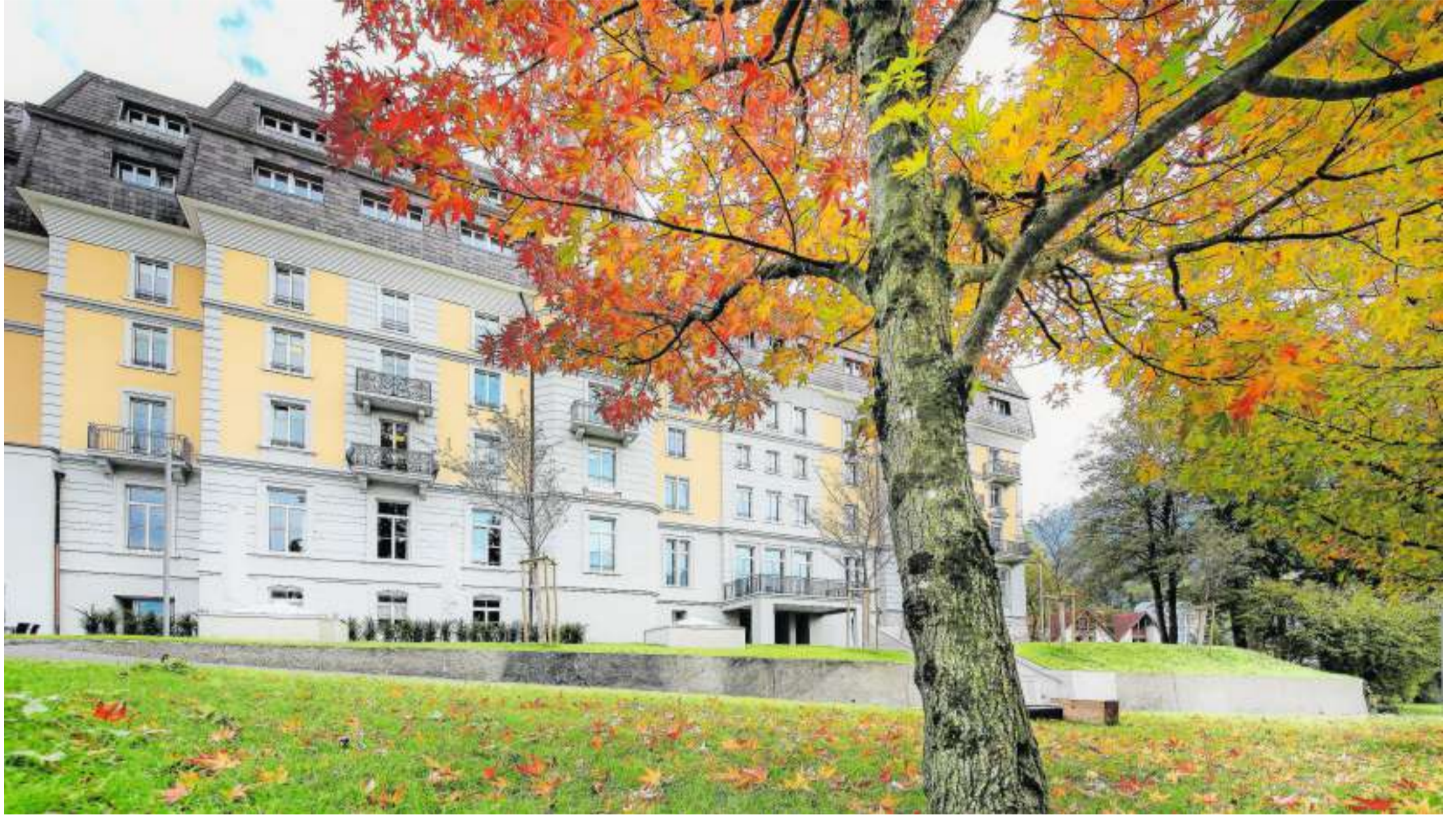
Die Seeklinik Brunnen wurde kürzlich für 25 Millionen Franken aufwendig renoviert.
